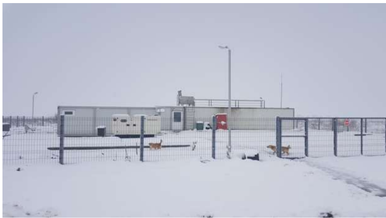
Figura 61 – Stație de epurare existentă Giuvărăști-Sursa de Finantare PNDL
