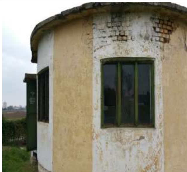
Cladire SPAU intrare Statie de Epurare
