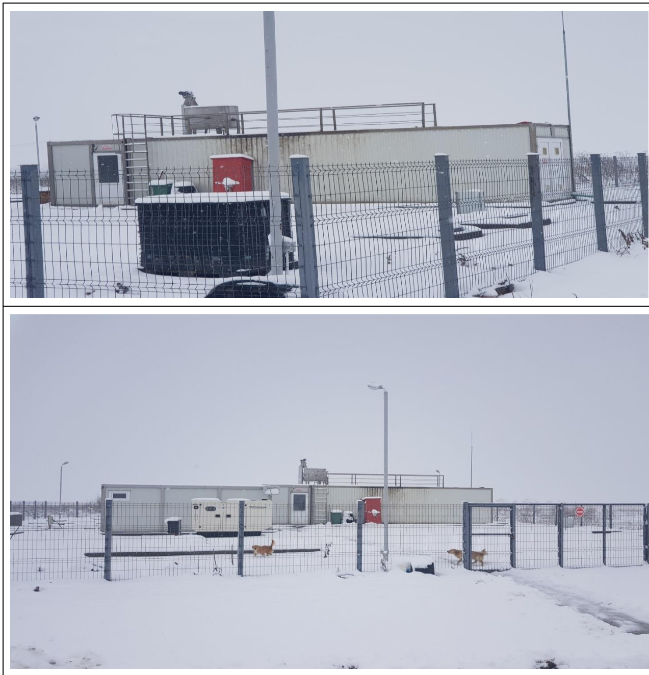
Figura 35 – Stație de epurare existentă Giuvărăști-Sursa de Finanțare PNDL
