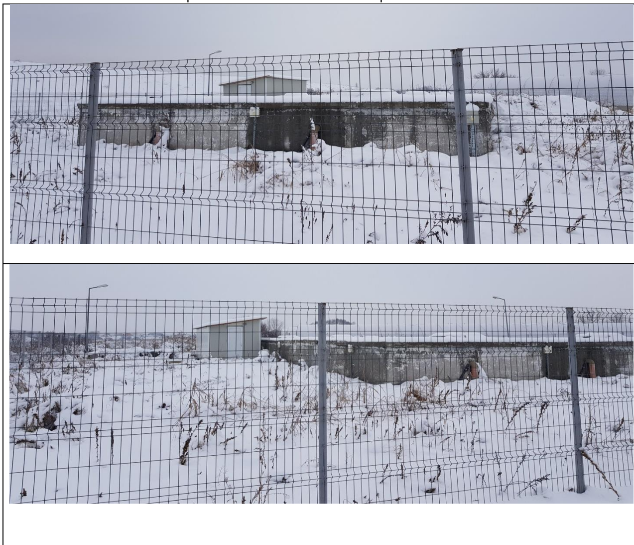
Figura 32 – Stații de epurare existente Izbiceni
