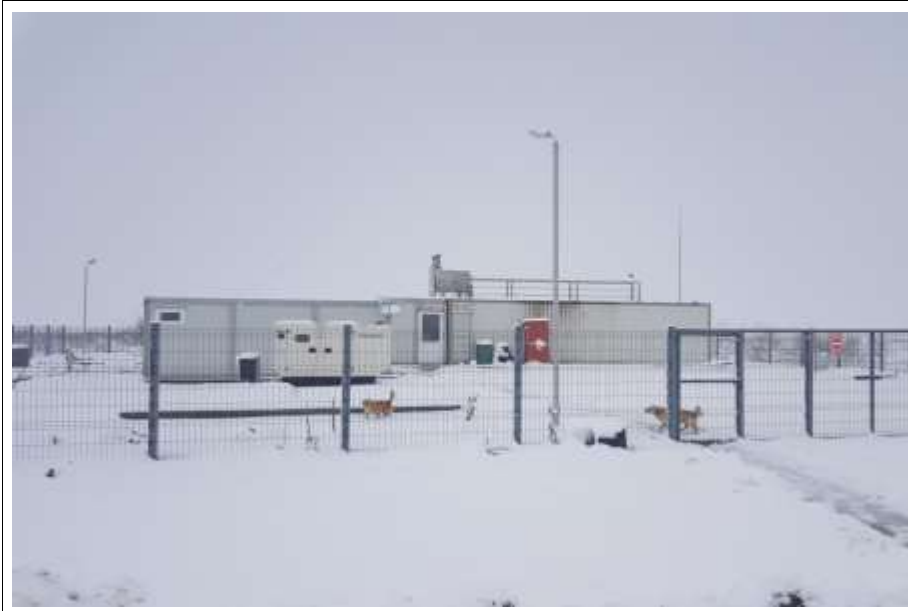
Figura 4 – Stație de epurare existentă Giuvarasti-Sursa de Finanțare PNDR
