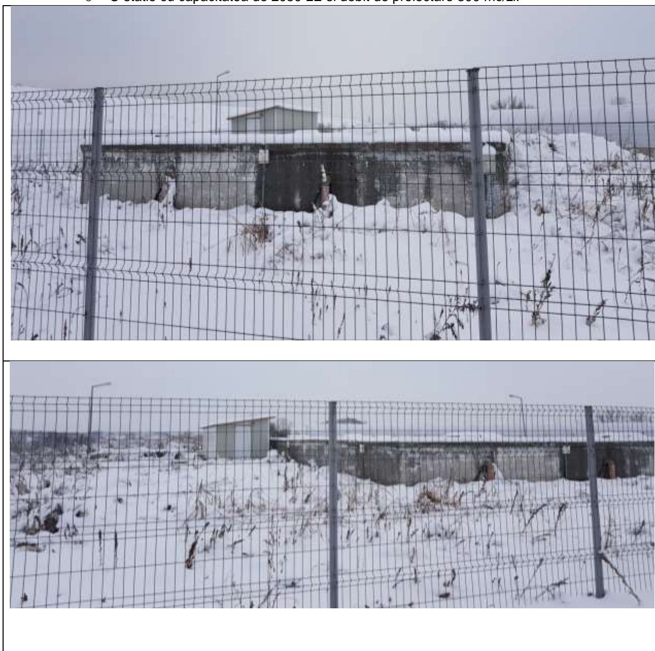
Figura 58 – Stații de epurare existente Izbiceni
