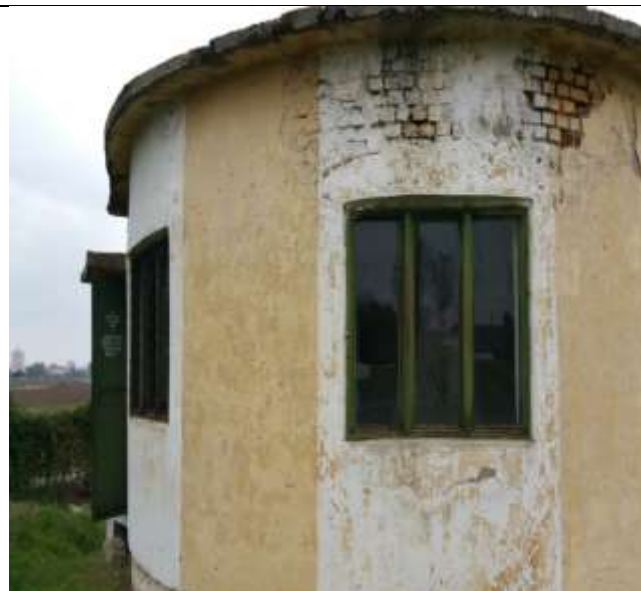
Cladire SPAU intrare Statie de Epurare
