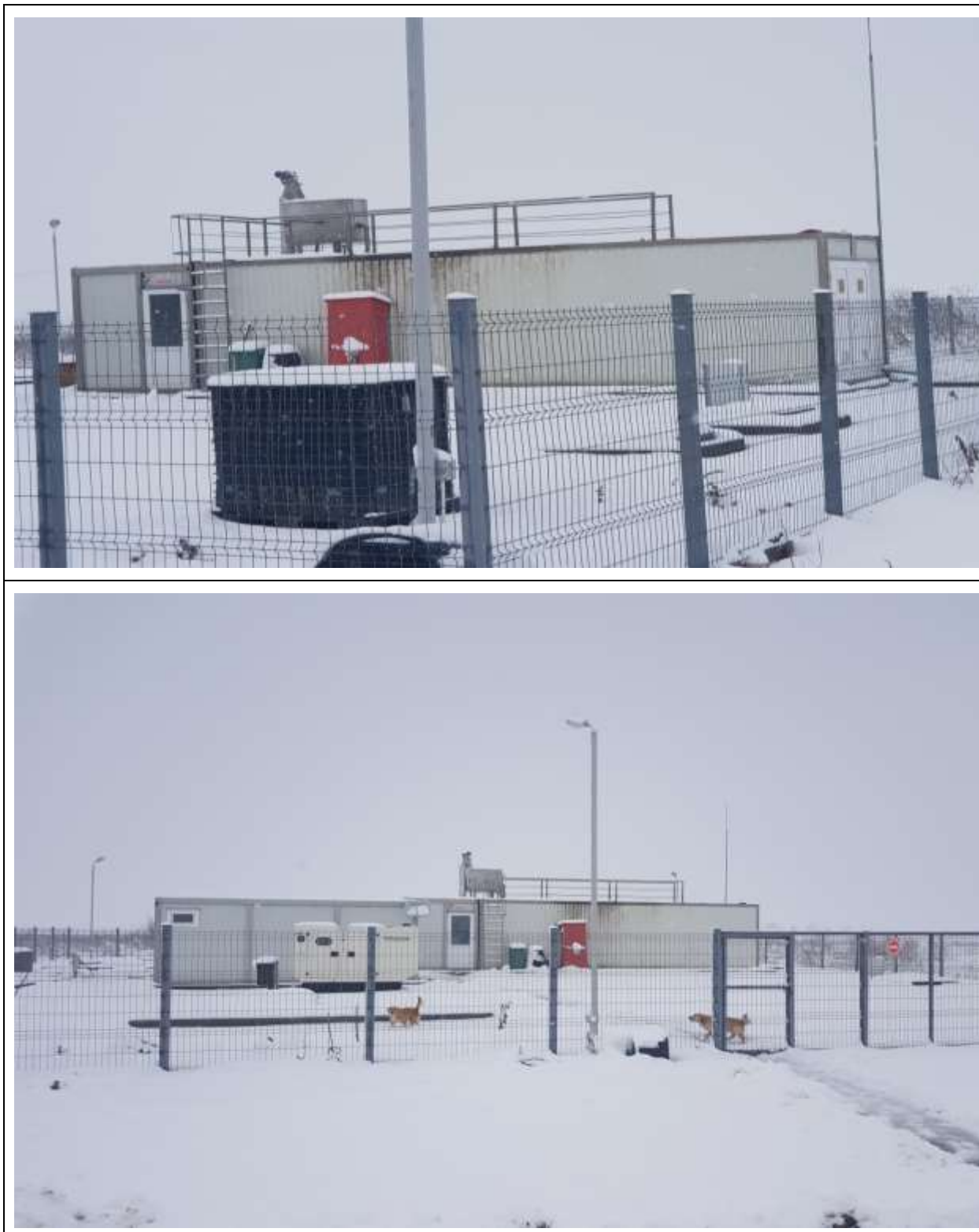
Figura 4 – Stație de epurare existentă Giugarasti-Sursa de Finanțare PNDL
