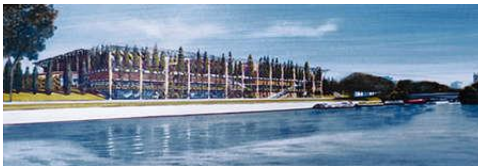
Fig 6.18 Instalația ISSEANE de valorificare energetică a deșeurilor municipale solide – incinerator de valorificare energetică în construcție într-un parc de lângă Paris. Instalația de 600 000 t/an va furniza, de asemenea, și încălzirea centrală pentru 90 000 de case și electricitate pentru 50 000 de case. Se estimează că stația va intra în funcțiune în anul 2007. Sursă SYMCOM, Regiunea Paris.
